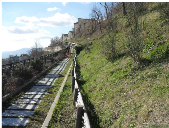
foto 2: - camminamento pedonale sottostante la scarpata da stabilizzare
