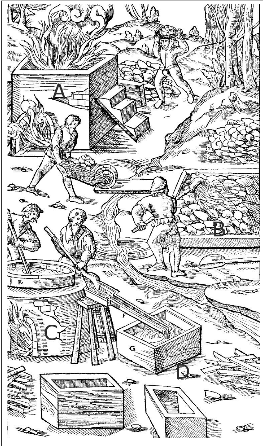
Fig.7 G. Agricola, De Re Metallica , 1556, tavola relativa alla lavorazione dell'allume.
