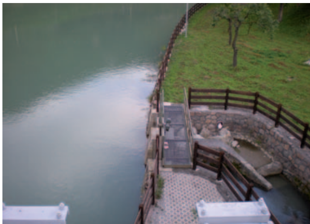
Impianto di risalita dei pesci della centrale idroelettrica "Claudio Castellani" nella Bassa Valle Isarco
