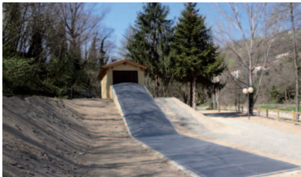
Impianto mini idroeltrico, Comune di Prato
