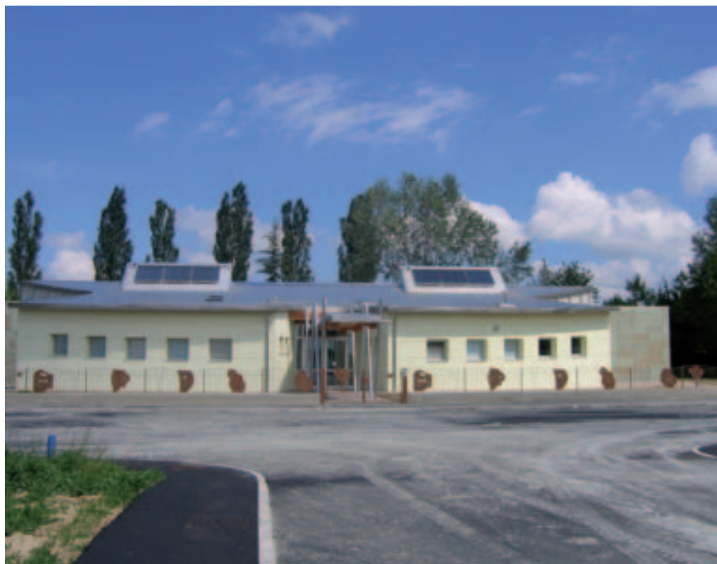
Impianto solare termico sulla copertura scuola dell'Unione della Bassa Romagna
