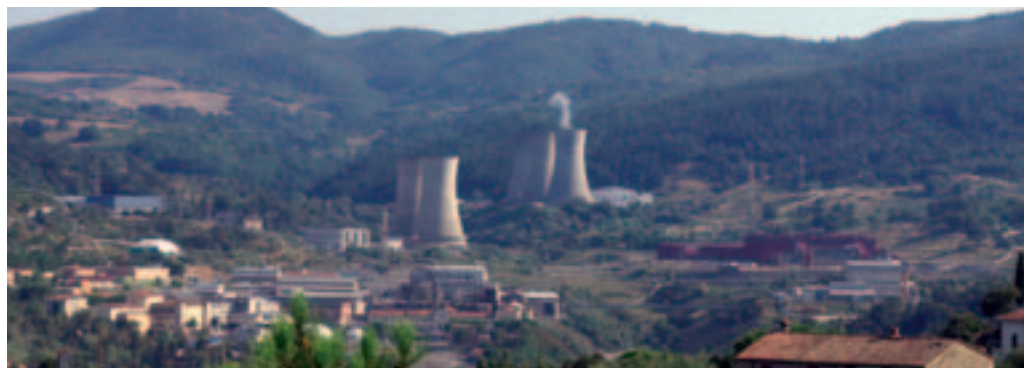
Impianto ad alta entalpia di Larderello nel Comune di Pomarance (PI)
