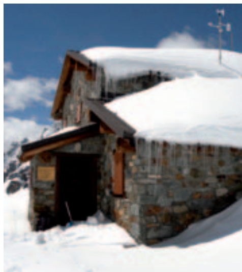
Rifugio Perrucca, servito da impianto mini idro, Comune di Valtournenche (AO)
