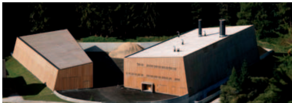
Impianto di teleriscaldamento nel Comune di Sesto (BZ)
