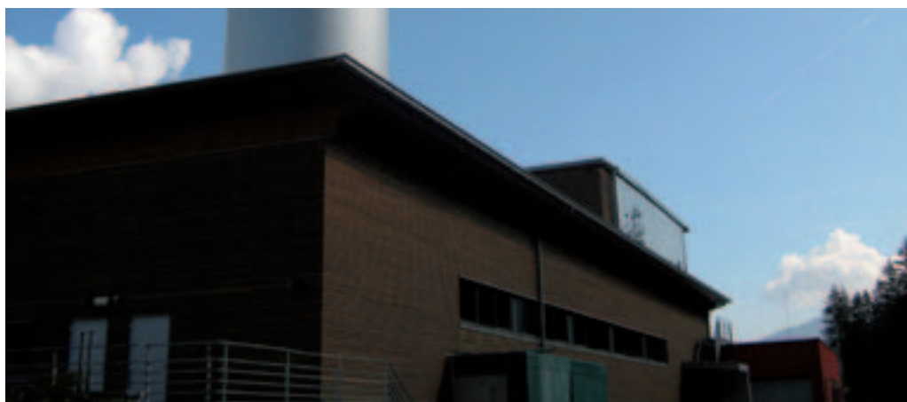
Impianto di teleriscaldamento, Comune di Dobbiaco (BZ)
