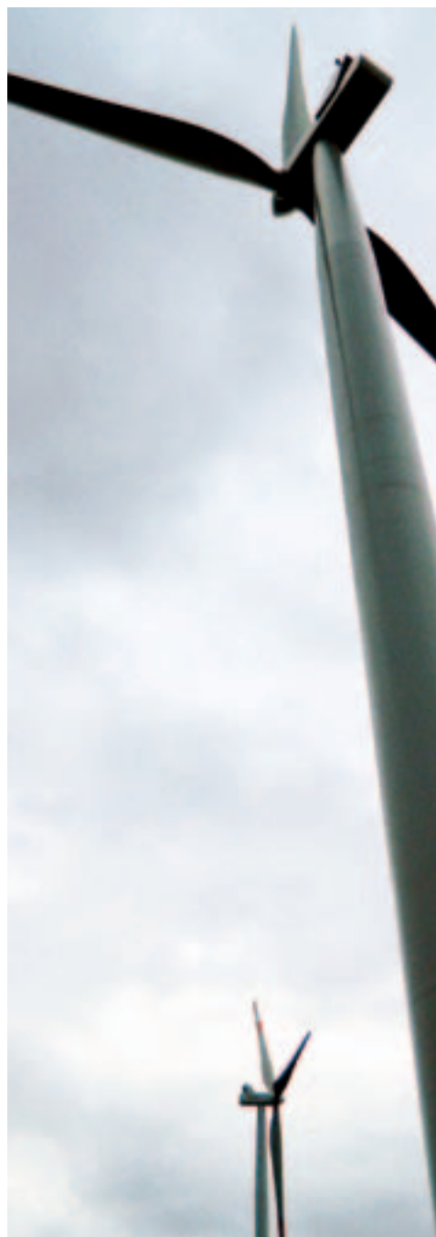
Impianto eolico, Comune di Santa Luce (PI)
