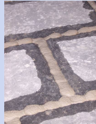
Particolare stuccatura pietre
