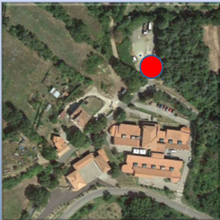
Aerofoto - Centrale Secondaria di Chiusdino
