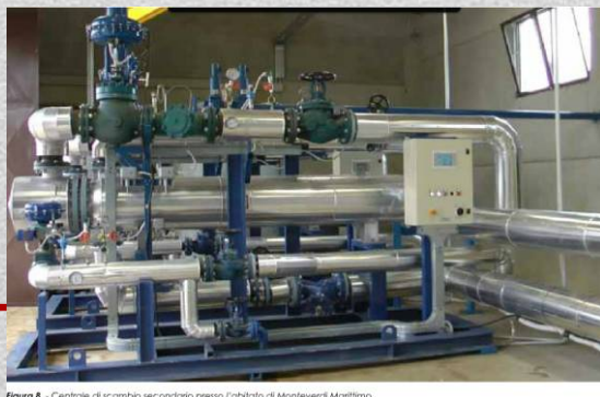
Figura 8. - Centrale di scambio secondario presso l'abitato di Monteverdi Marittimo
