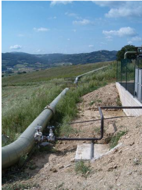
Spillamento dal vapordotto primario.
