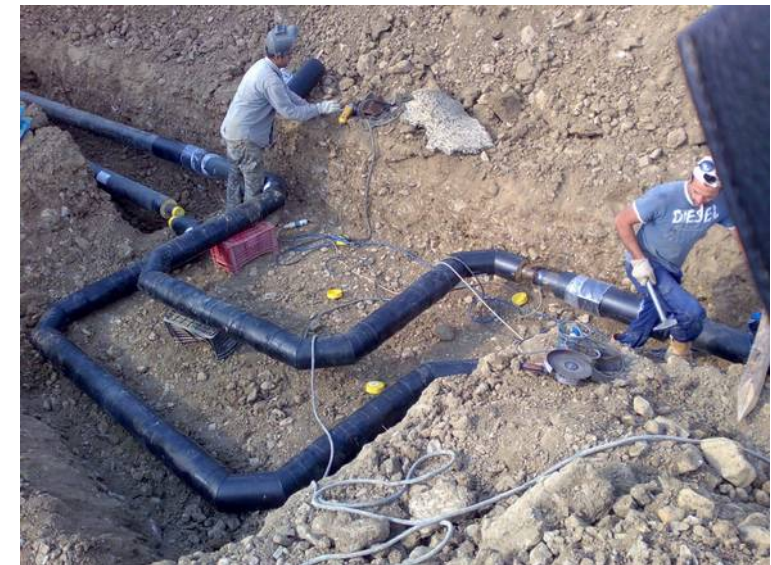
Spillamento dal vapordotto primario.
