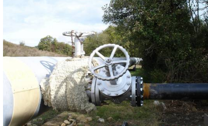
Esempi di punti di spillamento dal vaporedotto primario.
