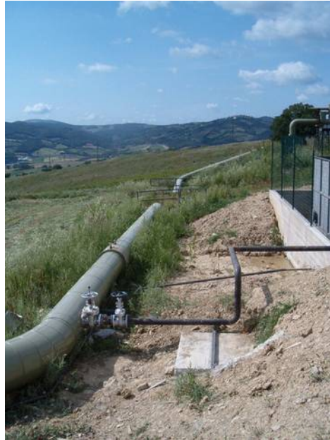
Esempi di punti di spillamento dal vaporedotto primario.
